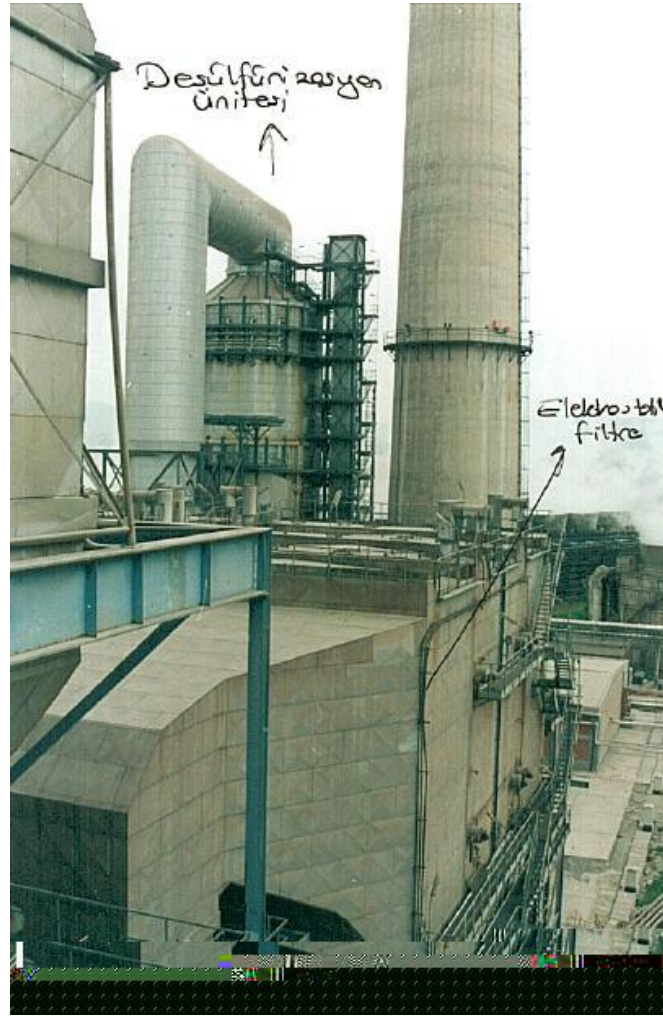
Şekil 2. Islak desülfürizasyon ünitesi (Yatagan Termik Santrali)
